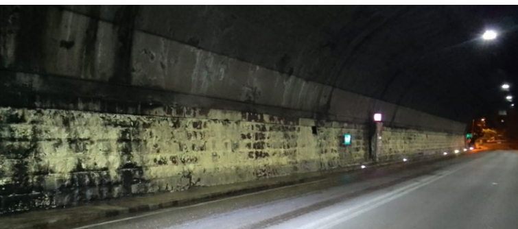
1. Lo stato in cui verteva la galleria Virgolo prima dell'intervento di pulizia e riverniciatura effettuati da Seven Service
