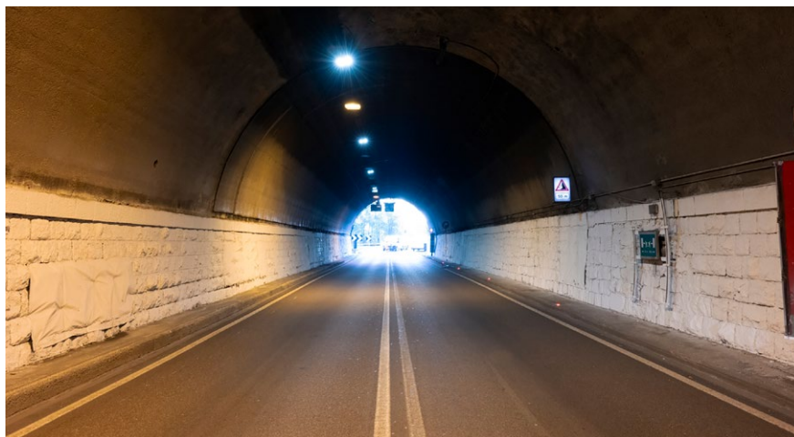
5. La galleria Virgolo come si presenta oggi. Fra i punti di forza dell'intervento, non solo la qualità del risultato, ma anche la ridotta durata dei lavori, fattore sempre molto importante quando si opera in strada
