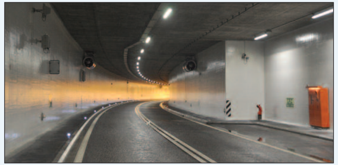
13. Il tunnel di Cheseaux dopo l'intervento di pulizia
