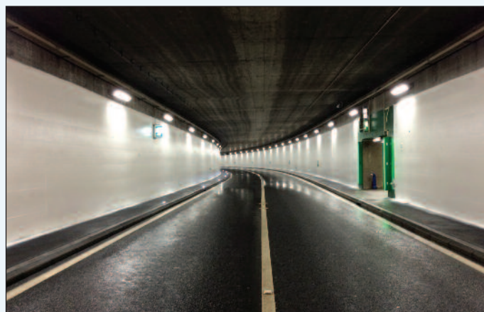
4. Il risultato finale del tunnel Marcolet
