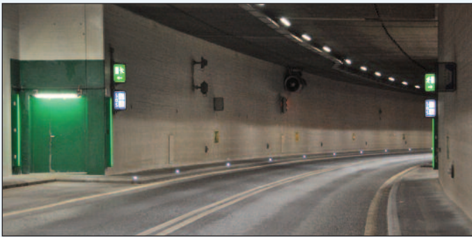
11. Il tunnel di Cheseaux prima dell'intervento di pulizia
