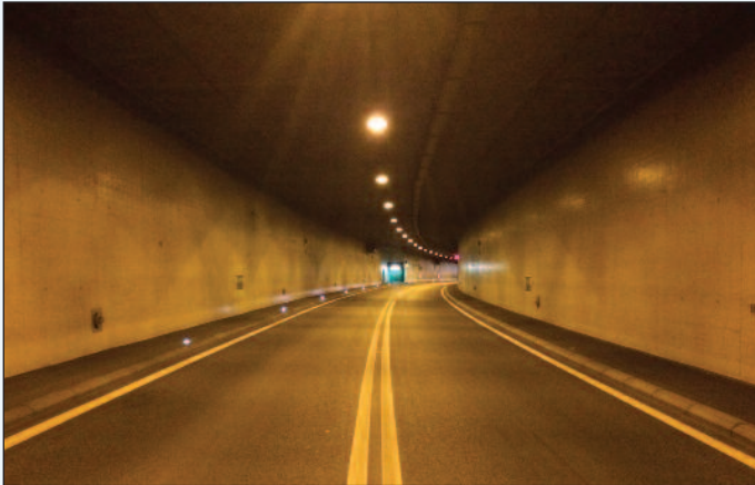
5. Le condizioni delle superfici prima dell'intervento di lavaggio
