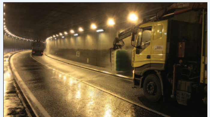
2. L’immagine mostra l’esecuzione del rotolavaggio delle superfici con evidenza della pulizia eseguita dal primo autocarro da 2 a 4 m dal piano viabile
