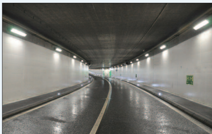
9. Il tunnel di Marcolet dopo l'intervento di pulizia
