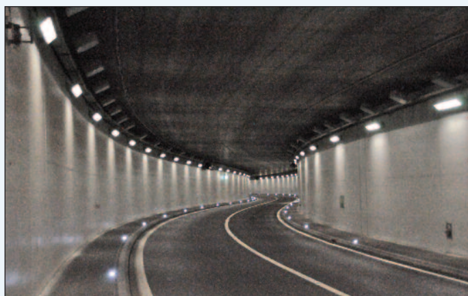
8. Il tunnel di Marcolet prima dell'intervento di pulizia
