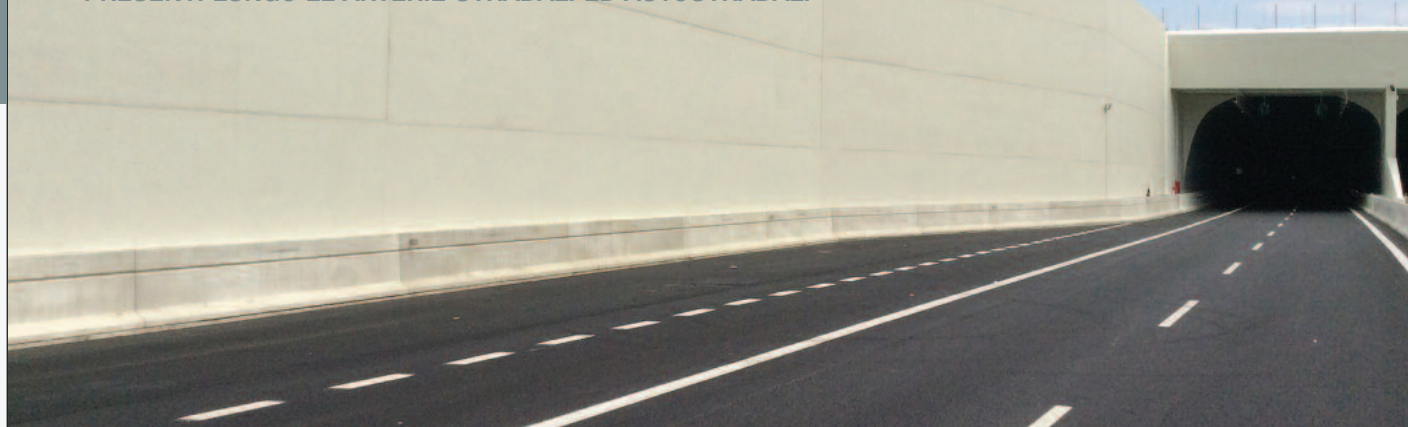
1. Un esempio di protezione del calcestruzzo
