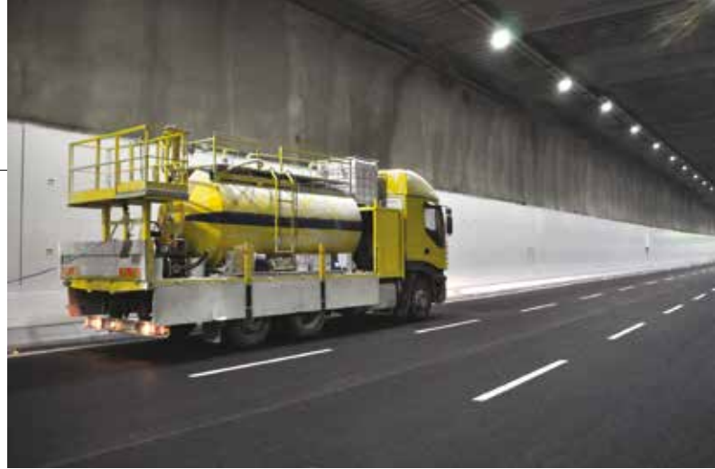
4. Un mezzo della Seven Service Srl durante la tinteggiatura dei piedritti in galleria
