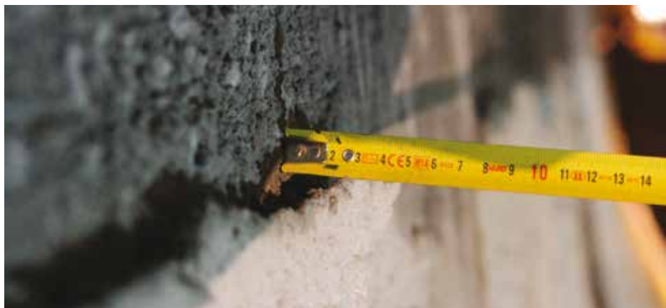
1. Lo spessore del film di vernice esistente in galleria
