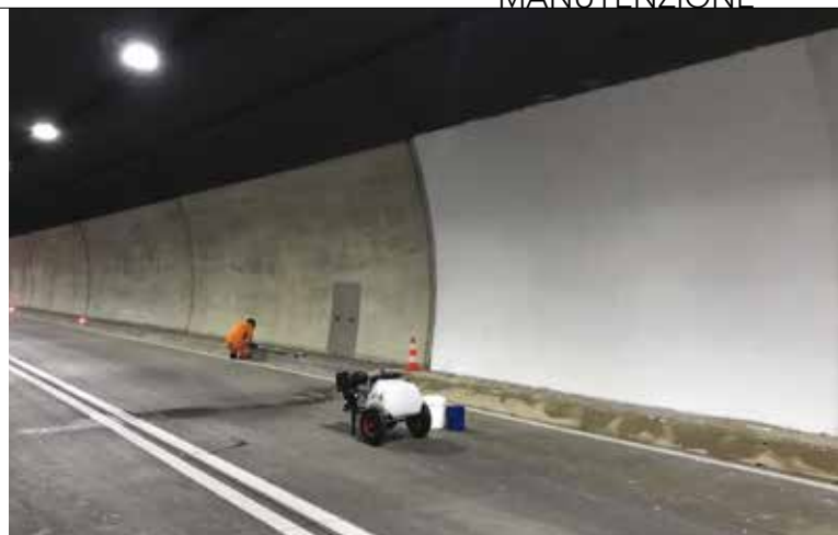
3. L'applicazione dimostrativa di malta rasante e verniciatura acrilica finale
